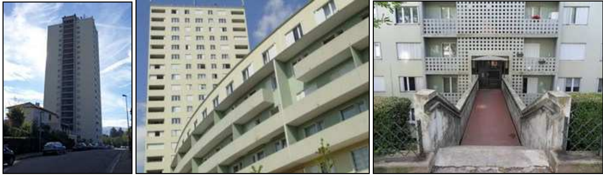
Images 143 à 145 : Tour, Rotonde et Passerelles de Beaulieu.
