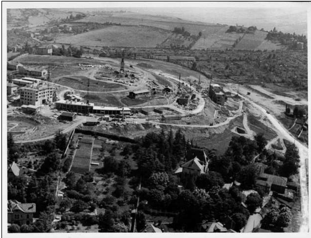
Image 80 : Le chantier de Beaulieu – Le Rond-Point Archives Métropole habitat Saint-Etienne
