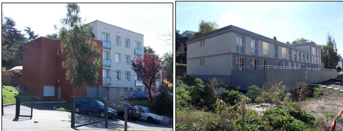
Images 48 et 49 : Immeubles HLM construits dans les GE du sud-est dans le cadre du projet ANRU.
