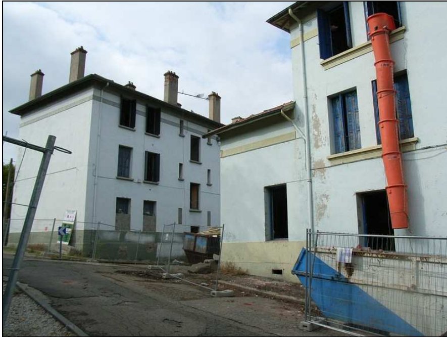
Image 165 : L'Ancienne cité de la Romière en travaux.
