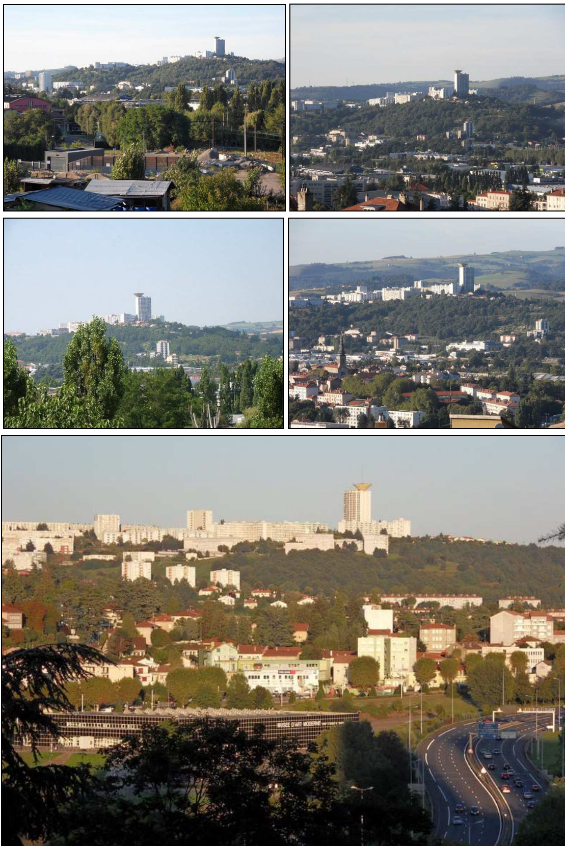
Images 137 à 141 : La tour Plein ciel vue des quartiers Bardot, Montplaisir, Méons, Villebœuf et Villars. R. Kaddour, septembre 2010.
