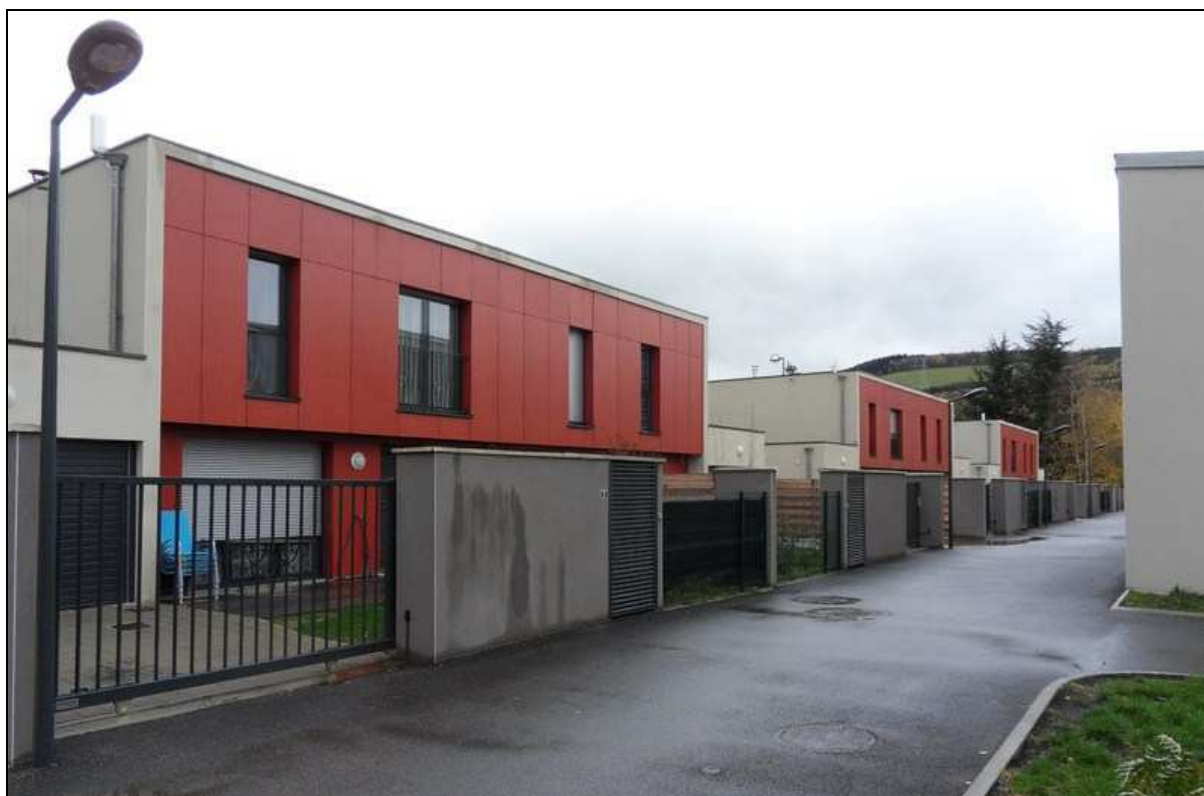
Image 50 : Maisons mitoyennes construites par la Foncière Logement à la Marandinière.
