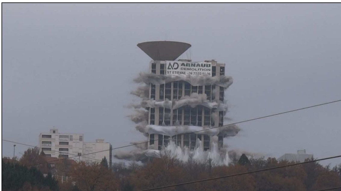
Image 136 : Démolition de la tour Plein ciel, 24 novembre 2011.
