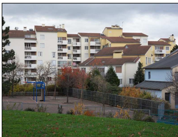
Images 36 à 38 : Immeubles dans le quartier Tarentaise. R. Kaddour, octobre 2010.
