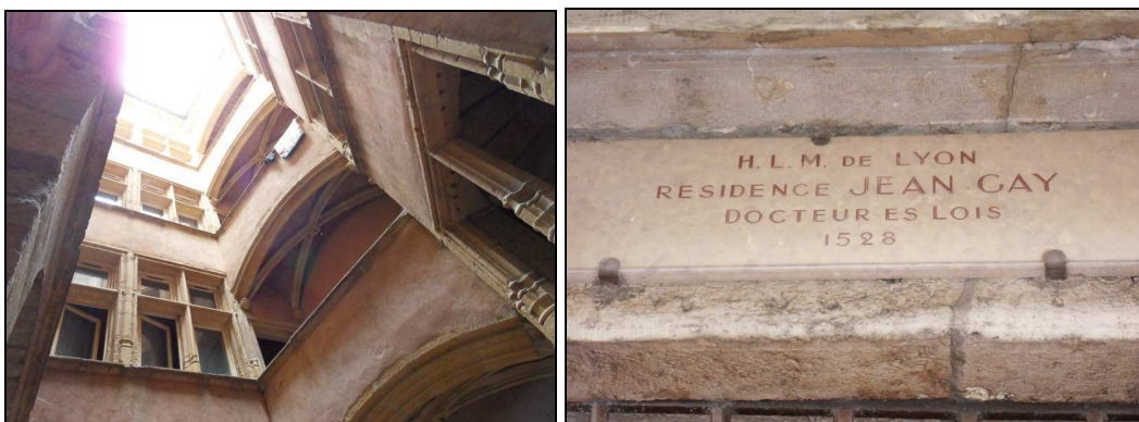
Images 182 et 183 : HLM dans des immeubles historiques, Vieux Lyon.
