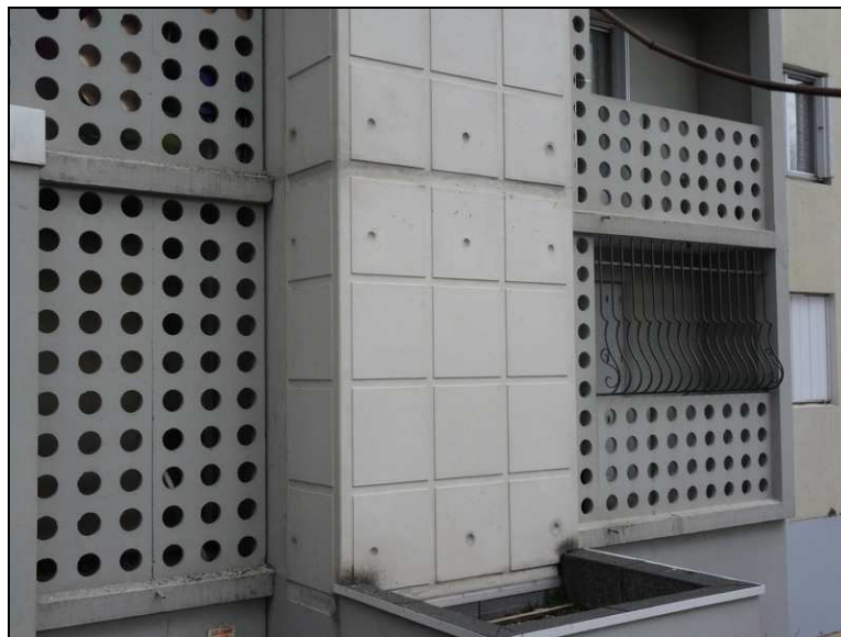
Image 103 : Motifs décoratifs en façade (ascenseurs), Beaulieu.
