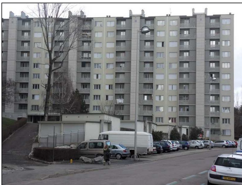
Images 104 et 105 : Avant et après les ascenseurs des immeubles de la rue Le-Corbusier (Beaulieu).
