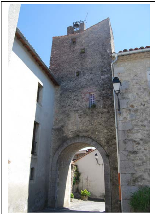
Fig. 8. Tour porte dite de l'horloge
