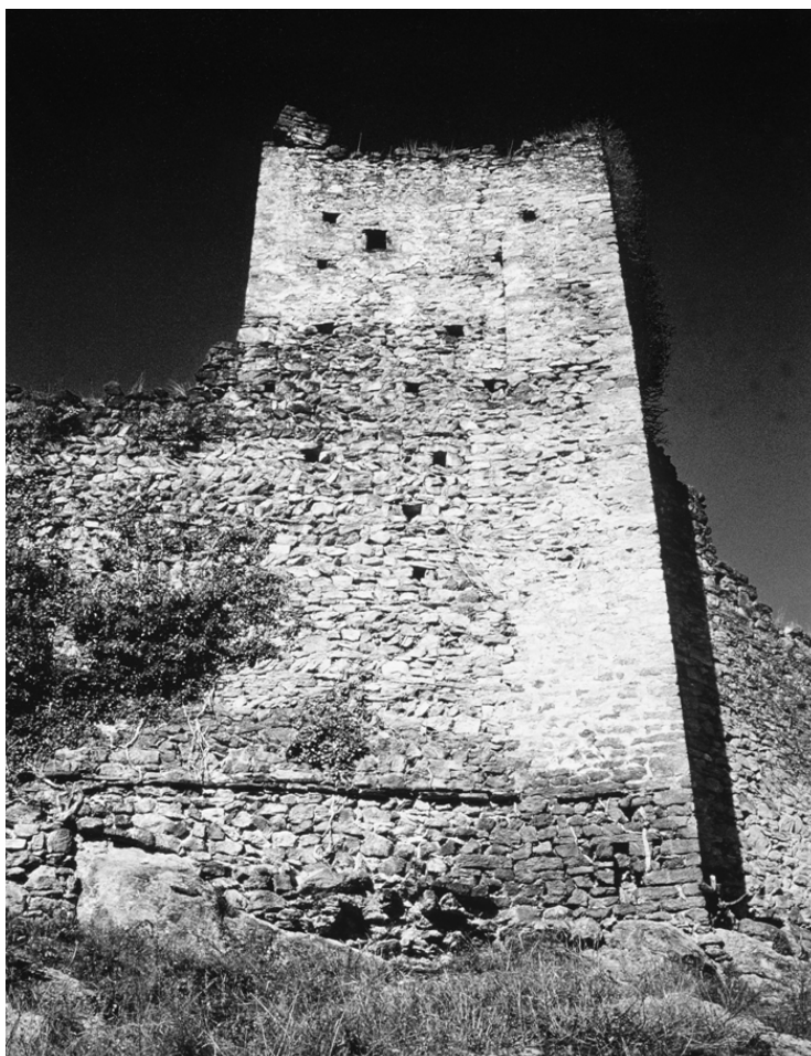
Tour de l'entrée, sud-est de l'enceinte, vu depuis le sud. Notez l'élargissement de la tour par le mur ajouté au devant et les arêtes de poisson de l'enceinte.
