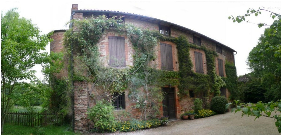
Fig. 10 : arrière du château moderne avec tranche du rempart de l'extension
