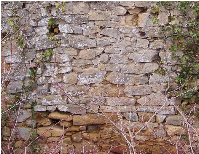
Salle 1, détail du mur intérieur est.
