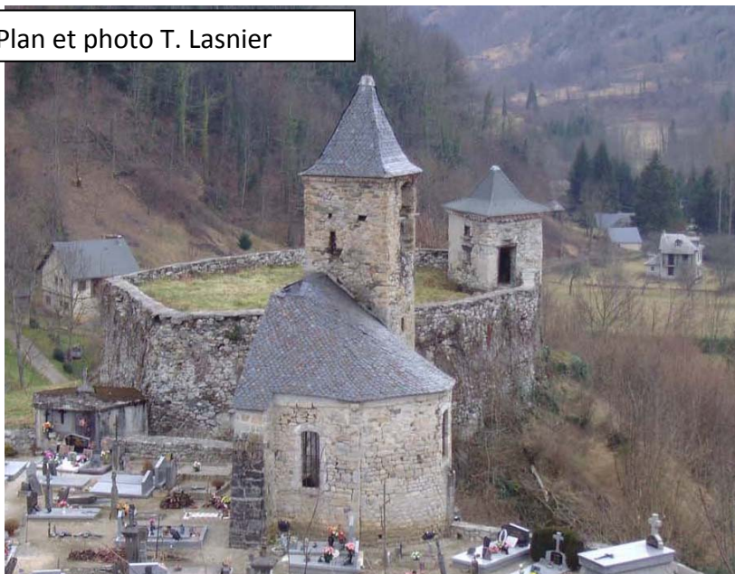
Fig. 205. Trein d'Ustou : vue générale sur le site
