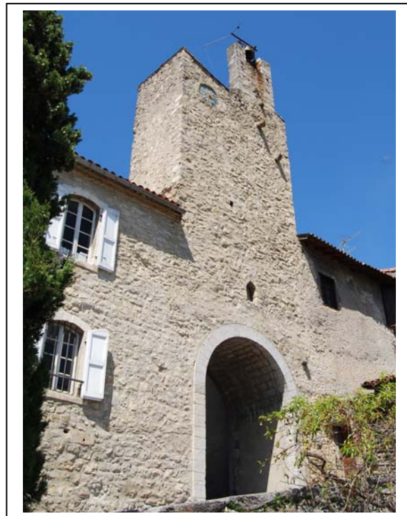
Fig. 9. Tour porte dite de l'horloge
