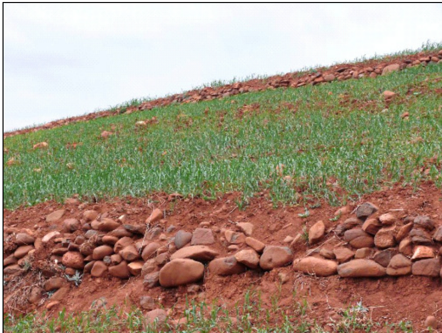
Figure 6 : Les murettes en pierres sèches
