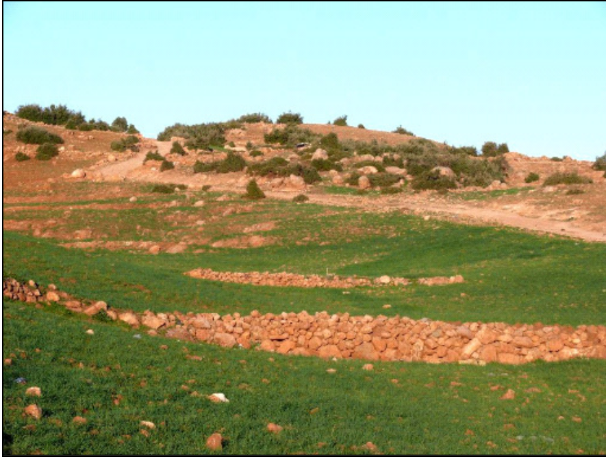
Figure 7 : Deux seuils en pierres sèches, en amont du village de Sidi Yahia ou Sâad
