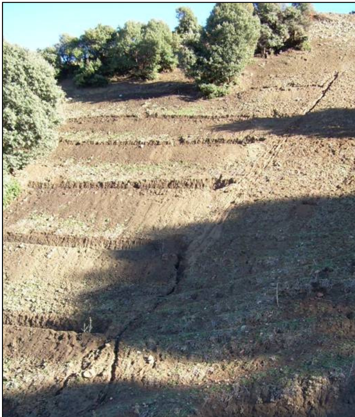
Figure 10 : Système d'irrigation avec une segouia installé par un agriculteur à Sidi Yahia et processus de ravinement
