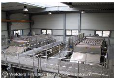
Figure 22 : Tables d'égouttage & tambour épaisseur.
