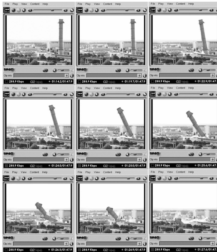
FIGURE 14 – Basculement de la cheminée G1 de Marcoule (Gard), le 19 juillet 2003 à 7h05 ( http://www.cea.fr/fr/thema/centres/valrho.htm )
