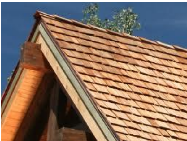
Bardeaux de toiture
