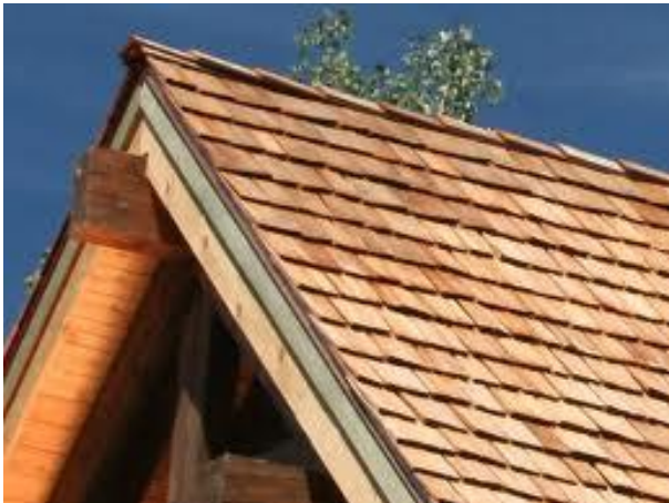
Bardeaux de toiture
