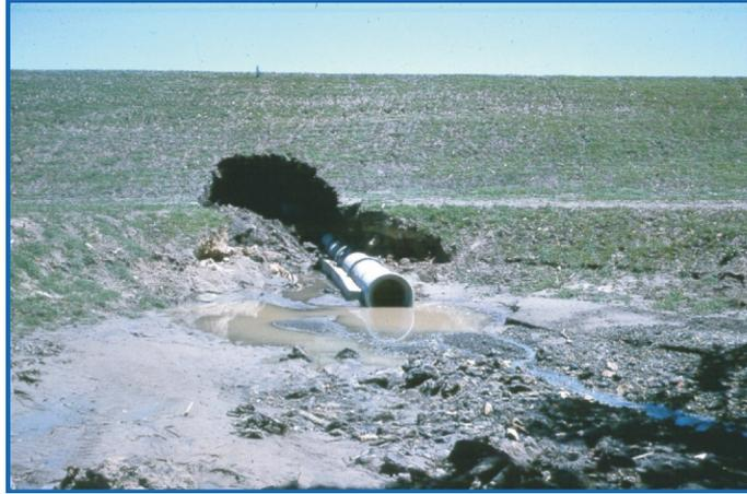
**FIGURE 1.9** – Désordre causé dans un barrage en terre suite au développement d'un renard le long d'une conduite.
