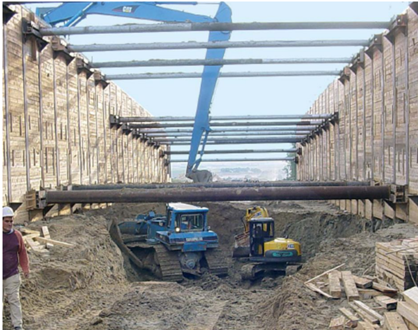
Parois berlinoises butonnées
