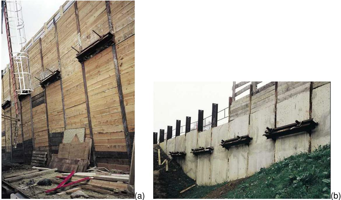
**FIGURE 4.6** – Paroi berlinoise avec un parement de bastaings (a) pour un usage temporaire, ou de béton armé (b).
