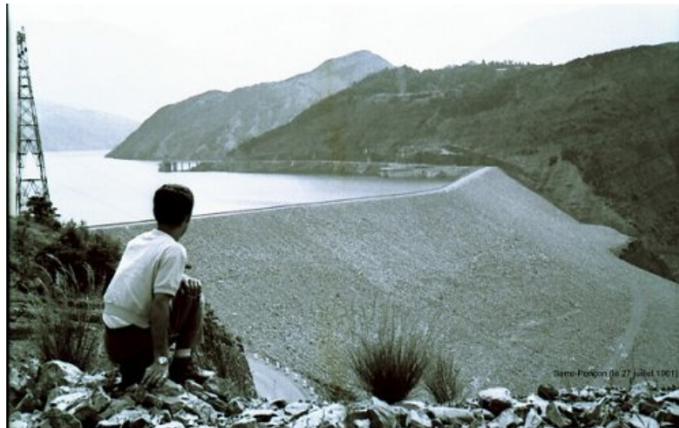
Barrage en terre de Serre Ponçon (Hautes-Alpes)
