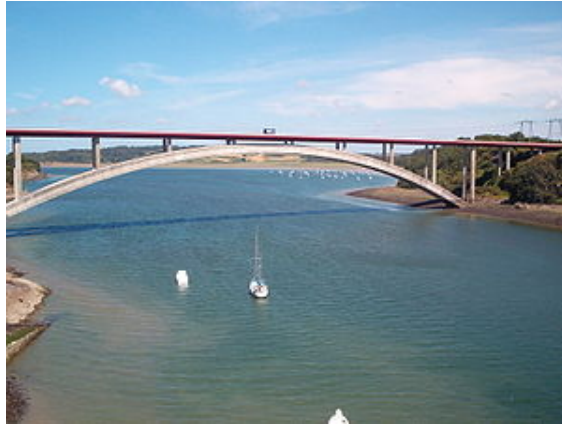
FIGURE 4.12 – Le pont Châteaubriand, pont en béton précontraint ayant la plus grande portée en France
