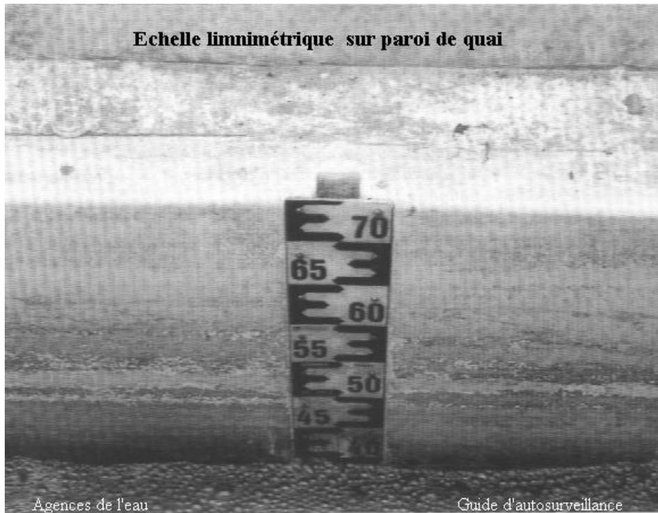
Il faut évidemment bien placer l'échelle, par exemple le voisinage des piles de pont reste à éviter en raison du ressaut hydraulique
