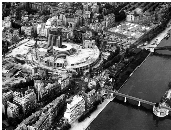
Fig. 3. Construction de la Maison de la radio et établissements Nozal (bureaux, magasins, entrepôts, logements), quai de Passy, Paris, 16 octobre 1959 (épreuve argentique, Paris, musée de Radio France).
