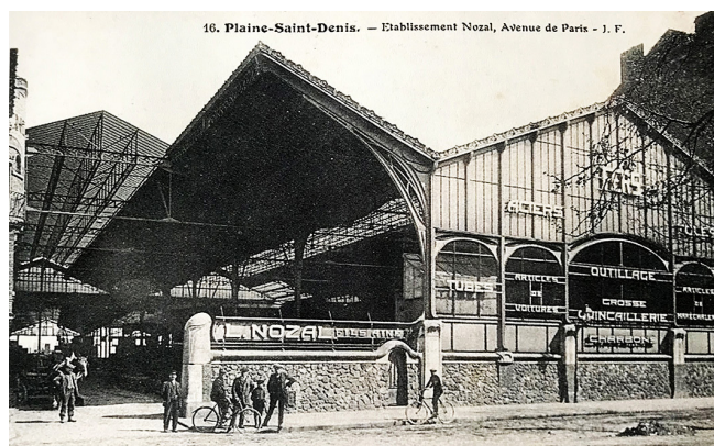
Fig. 6. Entrepôts et bureaux des établissements Nozal, avenue de Paris, Saint-Denis, 1902-1904 (carte postale, s. d.)
